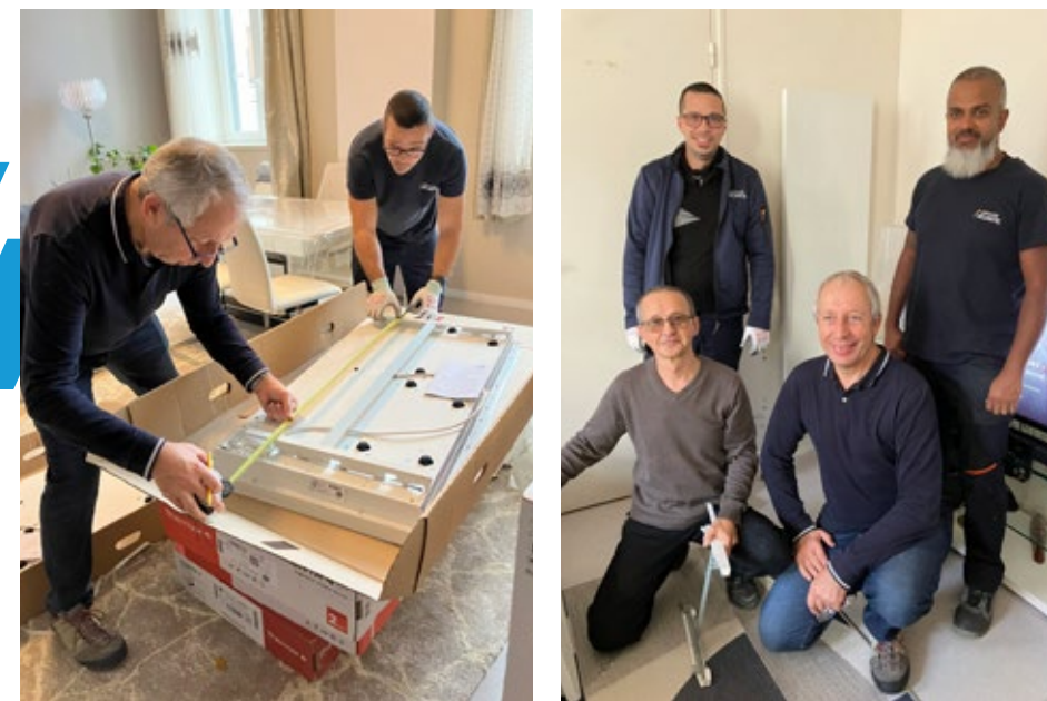
Don et installation d'appareils de chauffage dans une résidence Habitat et Humanisme d'Orléans
